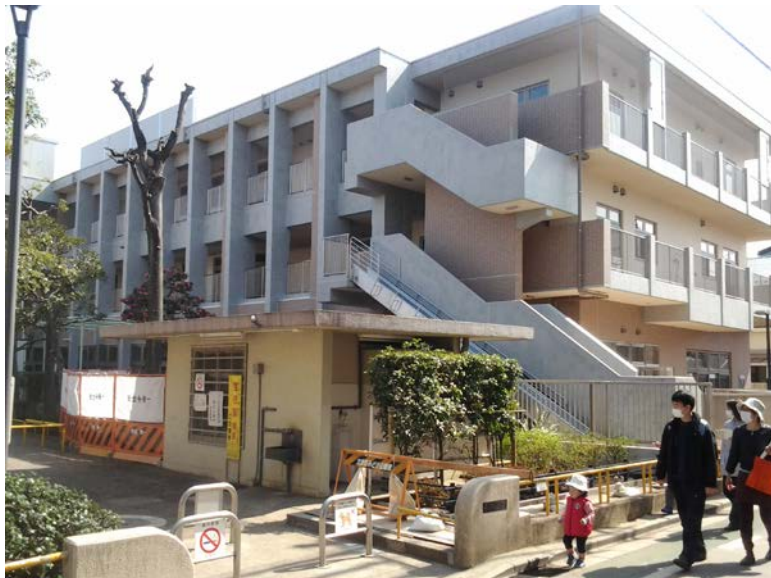
千石児童館内覧会 千石児童館と育成室がリニューアルされ子育てひろばも加わり、第1期工事が完了しました。
