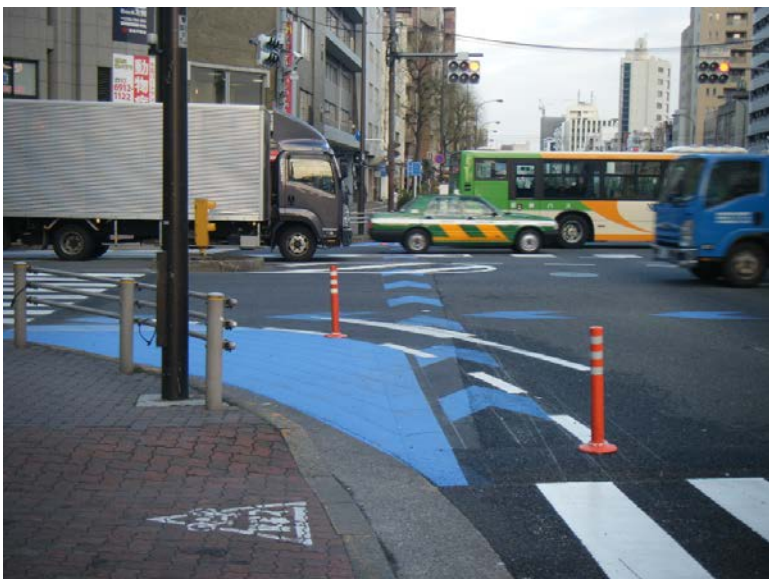
千石1丁目交差点自転車ナビライン 警視庁が都内で2ヶ所、試験的に自転車の交差点内通行帯を青いラインで示しました。(左折と直進をはっきりさせる目的です。)
